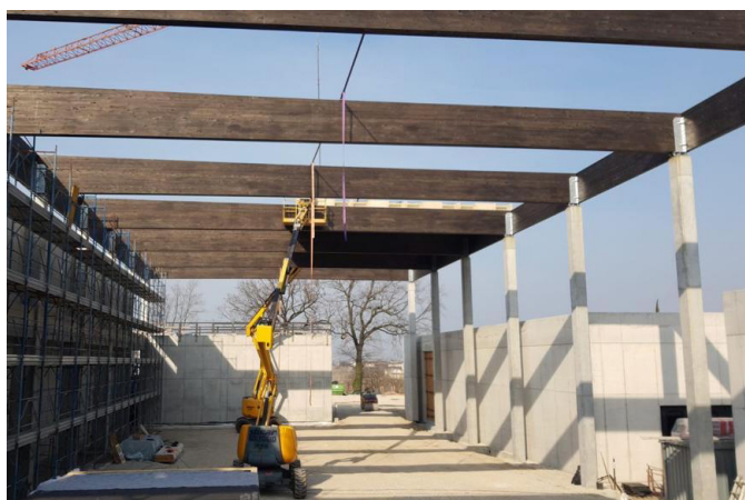
In questa foto e in alto, fasi della ristrutturazione della Cantina Sansonina a Peschiera del Garda.
